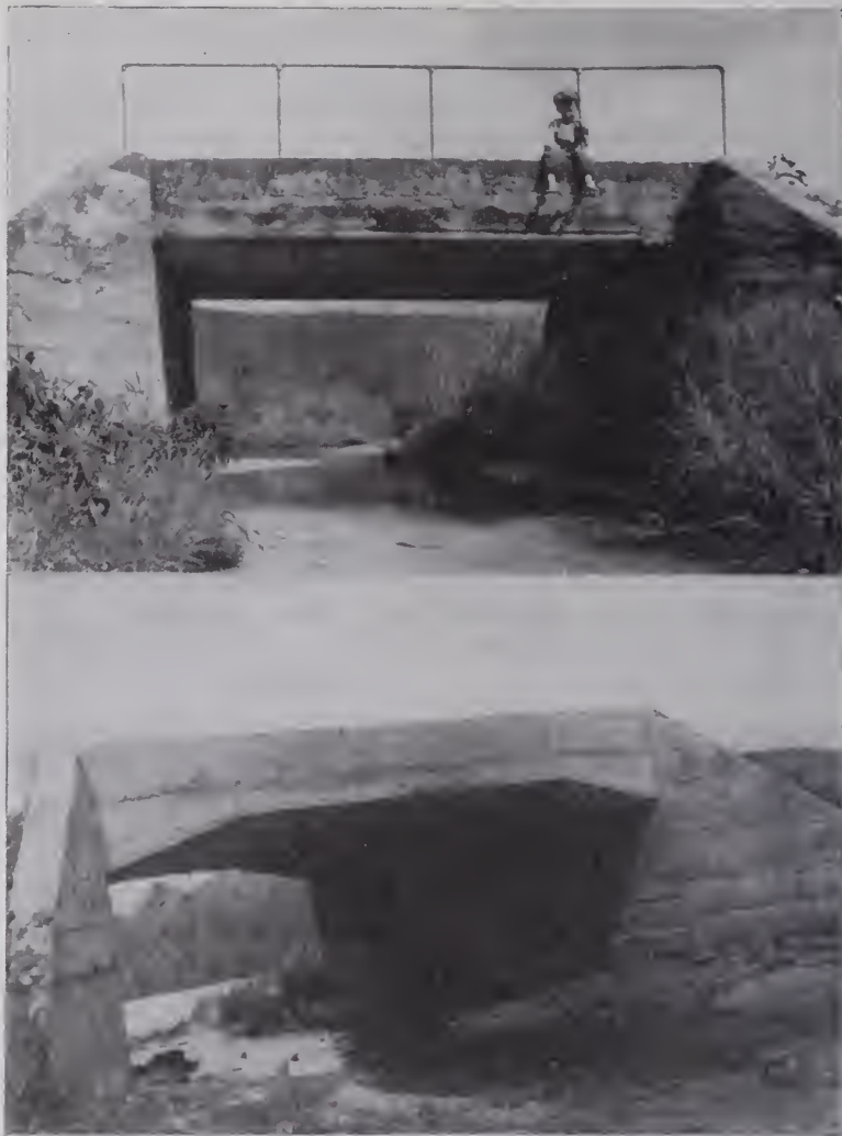
Primero y segundo puente, construidos de cemento armado por la Misión.
